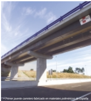
Primer puente carretero fabricado en materiales poliméricos de España
