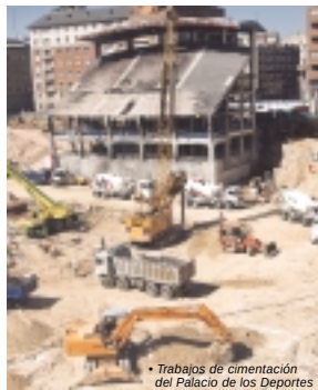
• Trabajos de cimentación del Palacio de los Deportes
