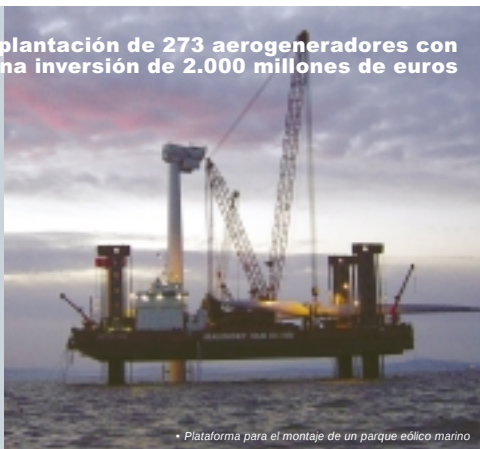
• Plataforma para el montaje de un parque eólico marino
