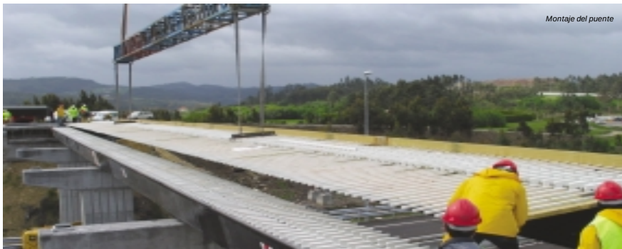
Montaje del puente
